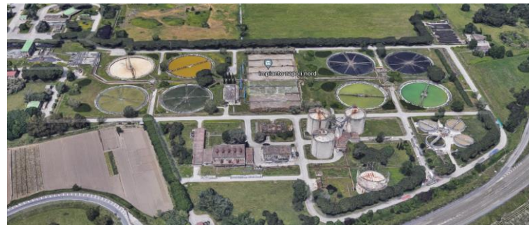
Impianto di depurazione «Napoli Nord»
